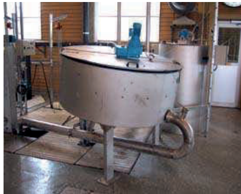
Figur 7: Skivefortykker fra Huber (Rotamat RoS2S)
