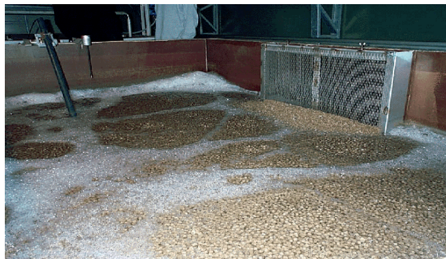
Figur 4: MBBR prosess (Kaldnes Moving Bed TM )
