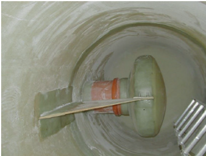
Figur 8.6.1. Virvelkammer montert i kum av GRP (Foto Miljø og fluidteknikk)
