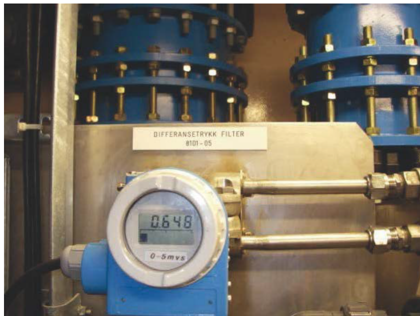
Figur 2-8 Differansetrykkmåler for en filterenhet.
