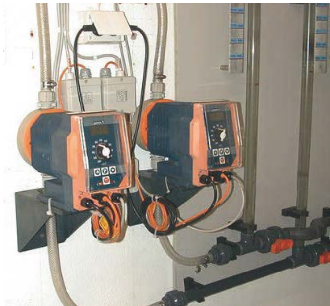
Figur 6-5 Typiske membranpumper (Prominent). Slaglengde stilles med skruen i midten av panelet. Frekvens stilles med trykknappene under skruen. Foto: F. Ording
