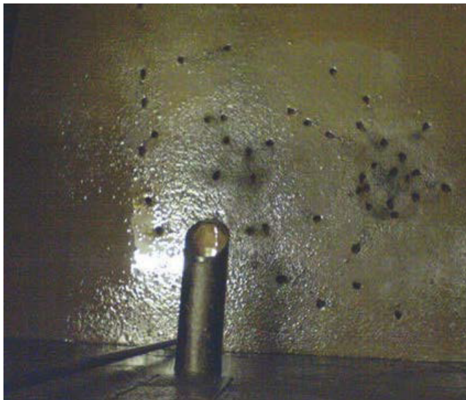
Figur 8-3 Belegg på filteroverflaten. Dette belegget ble fjernet manuelt ved avskrapning med godt resultat (Foto: T. Monstad)
