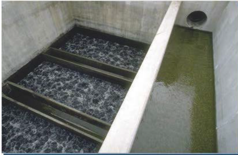
Figur 8-2 Filter under tilbakespyling med luft
