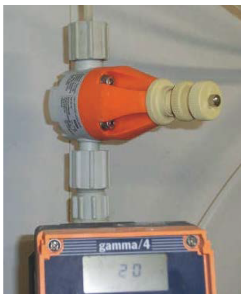
Figur 6-6 Eksempel på doseringspumpe (ProMinent Gamma 4) med DHV-RM mottrykks-ventil. Foto: F. Ording
