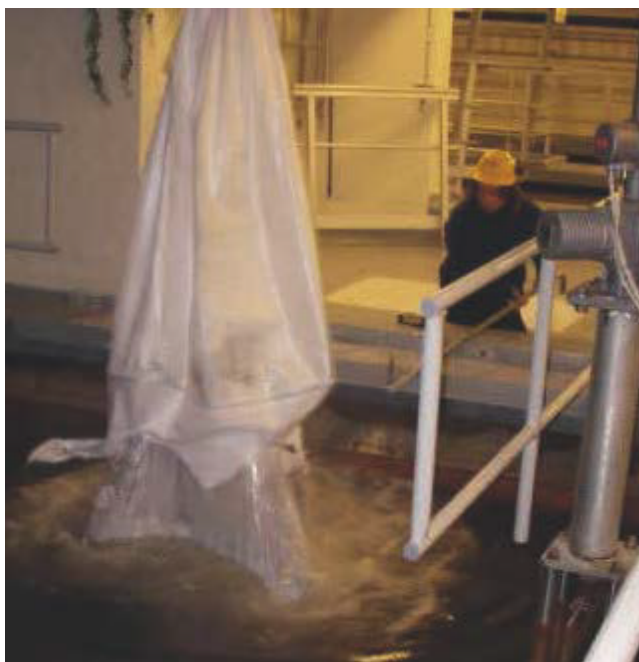
Figur 8-8 Fylling av alkalisk filtermasse fra storsekk (Foto: J. Røstum)
