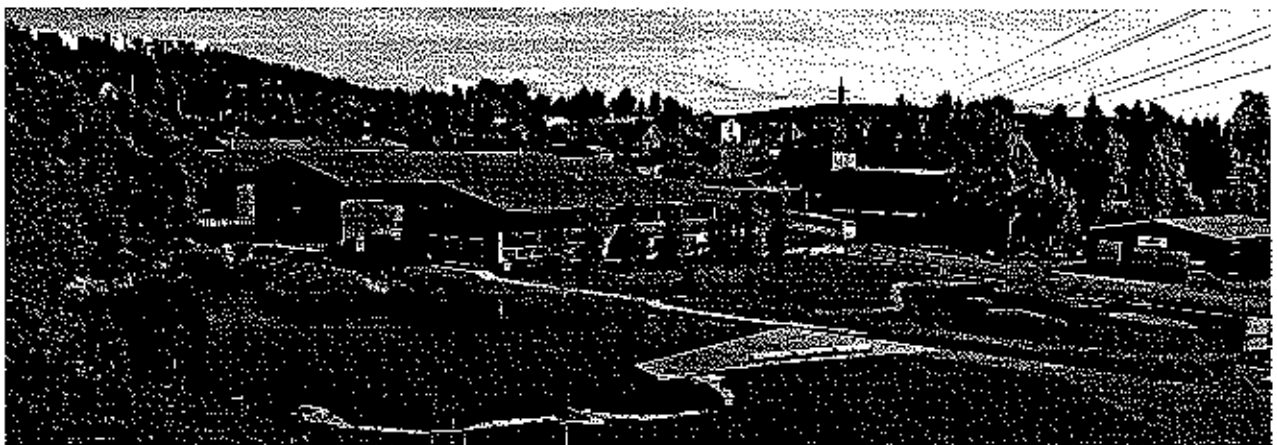
Figur 2.11: Eksempel på åpen overvannsløsning fra Hølatokka i Oslo.
