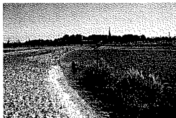
Figur 2.25: Filtrevoll i en fordrøyningsvoll for overvann. Foto: Ulf Thysell.
