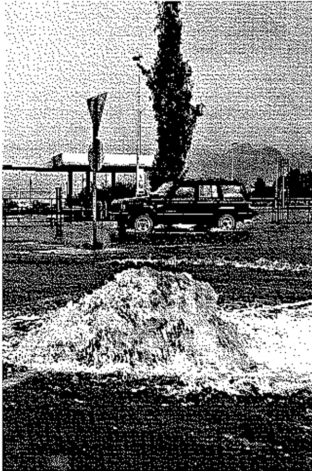
Figur 2.9: Overbelastet overvannsledning
